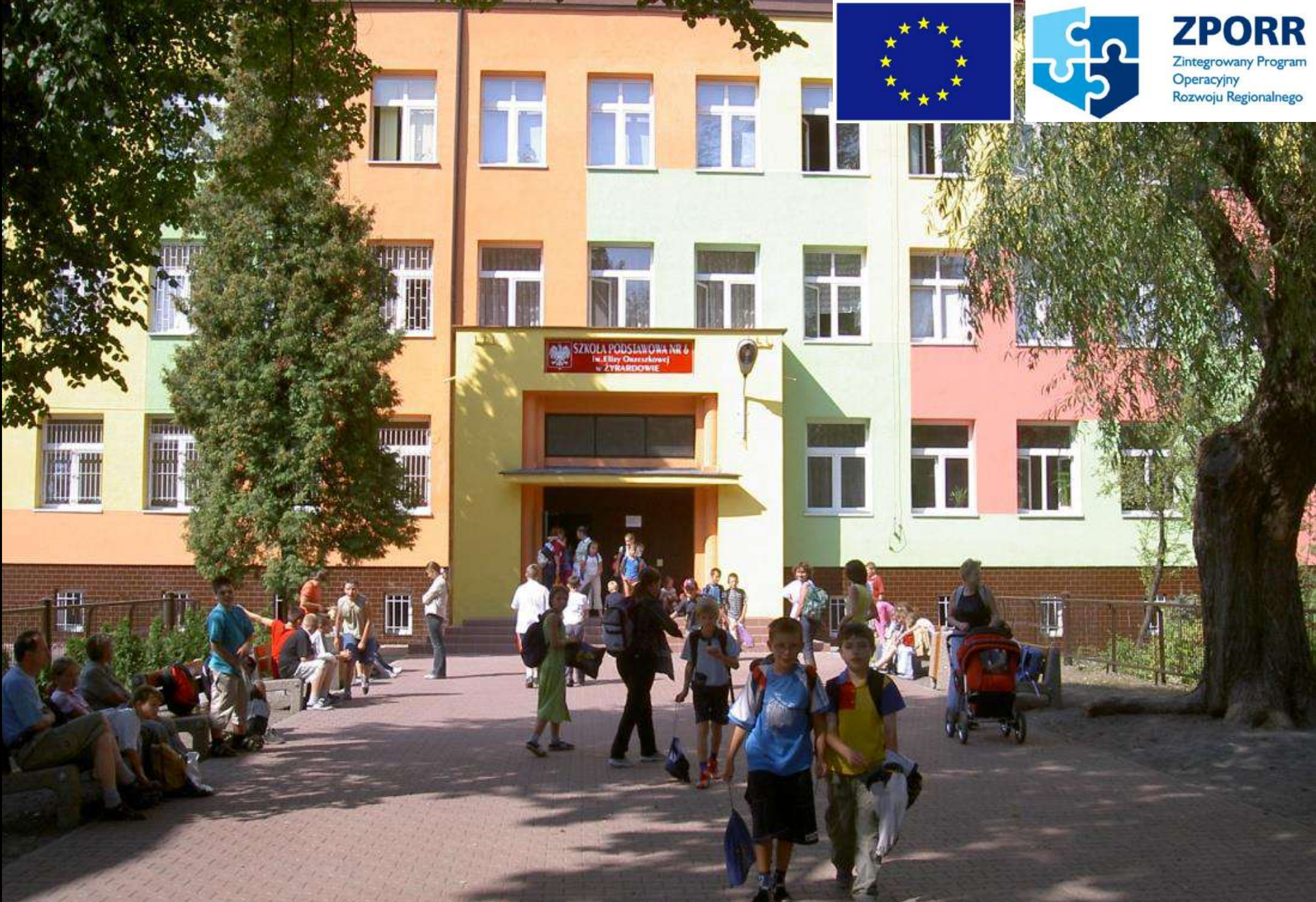
Przebudowa i remont Szkoły Podstawowej Nr 6 – po remoncie ZPORR 2004-2006
