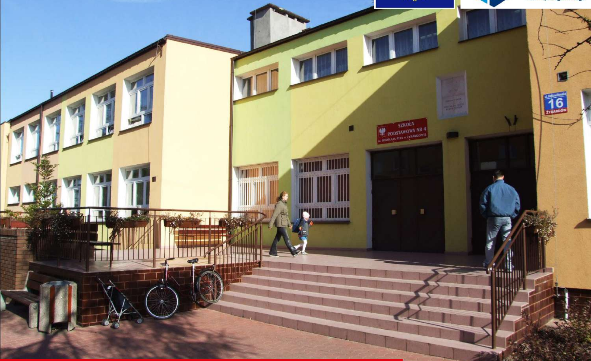
Przebudowa i remont Szkoły Podstawowej Nr 4 – po remoncie ZPORR 2004-2006
