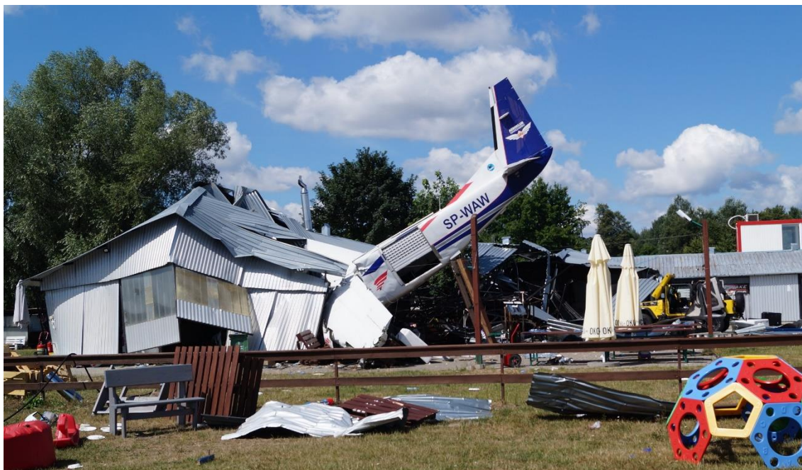
Rysunek 7. Zniszczony na skutek wypadku budynek znajdujący się na terenie lądowiska Chrcynno – przed budynkiem widoczne parasole, ławki, stoliki i elementy placu zabaw dla dzieci
