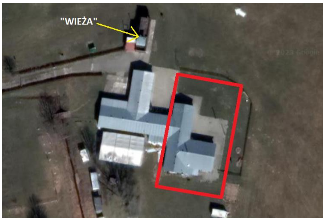
Rysunek 6. Budynek na lądowisku częściowo zniszczony podczas wypadku samolotu Cessna 208B, SP-WAW. Czerwoną ramką oznaczono zniszczoną część budynku [źródło: https://www.google.pl/maps ]
