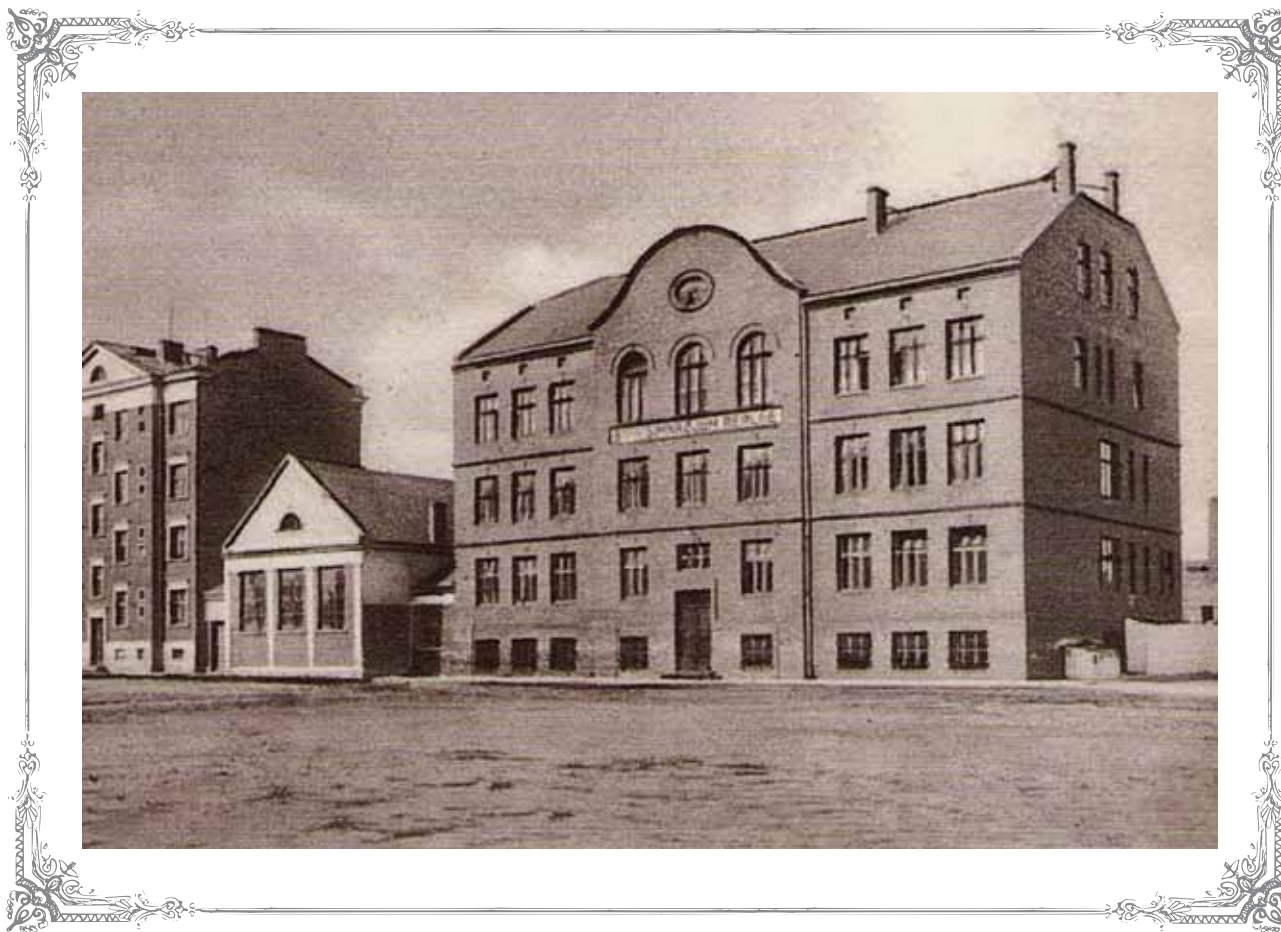
Dawne Gimnazjum Realne, następnie liceum – obecnie budynek Sądu Rejonowego w Żyrardowie (1937 r.)
