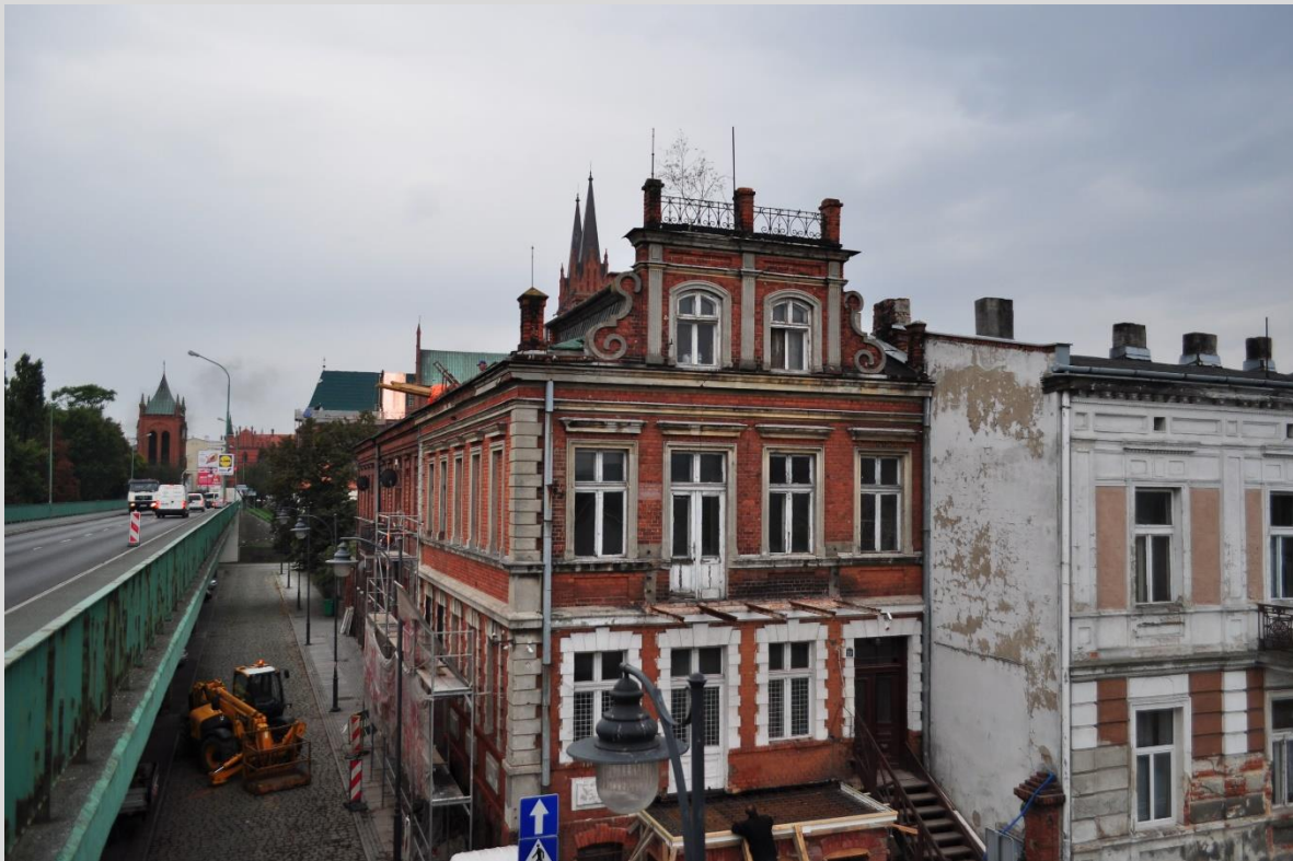
Zdjęcie 2. Ulica Bulwary 27 – przed remontem oraz rozpoczęcie prac
