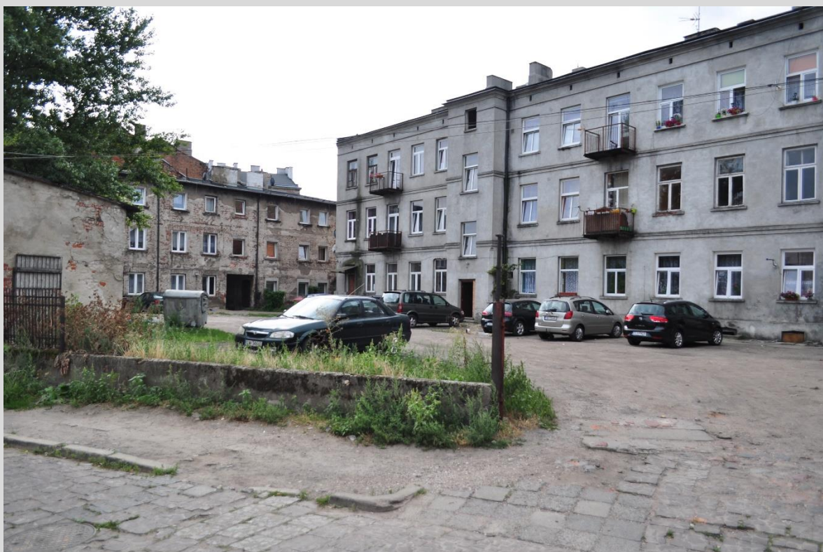
Zdjęcie 1. Ulica Brzeska 23 – przed remontem i w trakcie prac
